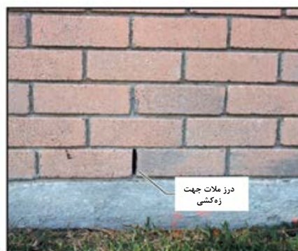
شکل ۵-۱۳- خالی گذاشتن درز ملات جهت زه‌کشی
