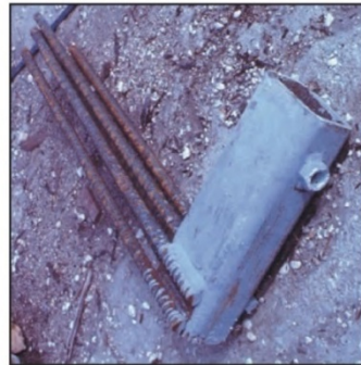
شکل ۱۰-۵- پروفیل قوطی شکل به عنوان تکیه گاه اتکایی و پیچ تنظیم ارتفاع
