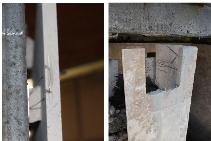
شکل ۲-۴- نمونه‌هایی از مه‌ارهای سیمی فولادی
