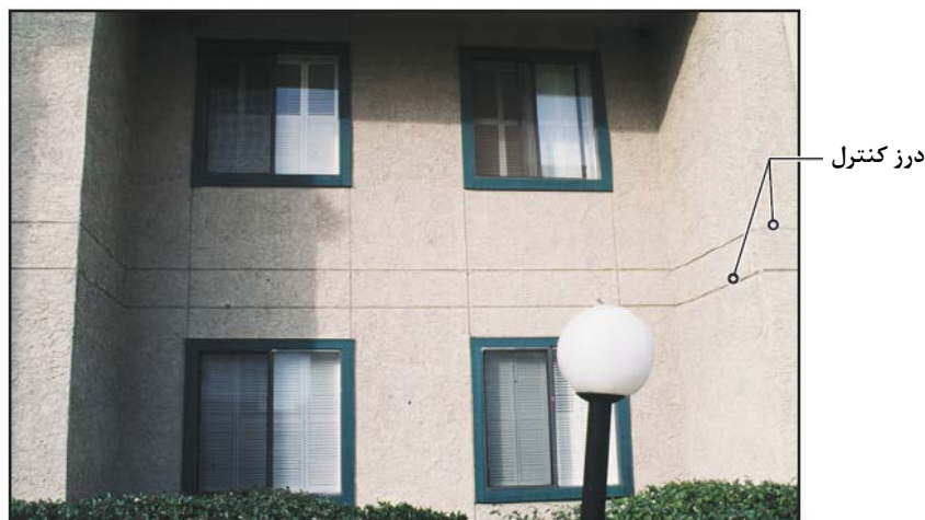
شکل ۶-۲- نمونه درزهای کنترل بر روی نمای سیمانی
