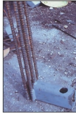
قوطی فولادی جهت تکیه گاه اتکایی (ب)
